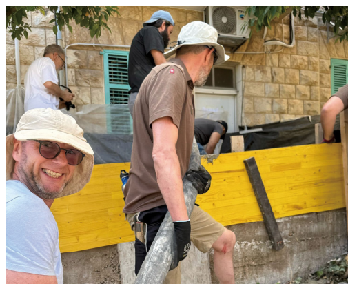
写真 上:ハイファハウスの屋上にて (左がマルクス)、スイスからのチームと。 左:ハイファハウスの新しいフェンスを建設
